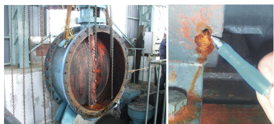
劣化した部品の例
