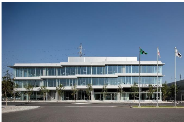
＜一般建築物の部＞KIND Center（市原市）
