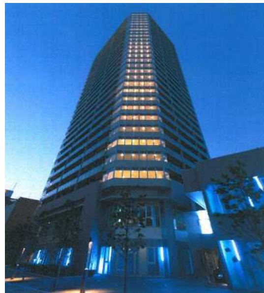
柏駅東口A街区第二地区（ザ・カシワ・タワー）
