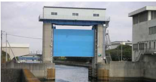
高潮対策事業 千葉港海岸（船橋地区）
