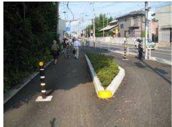
県道市川印西線（船橋市）
