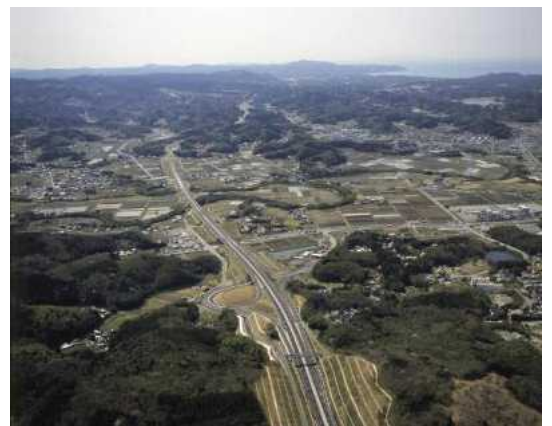
館山自動車道（君津市）
