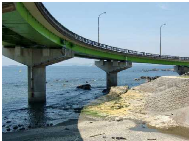
県道浜金谷停車場線 浜金谷橋（富津市）
