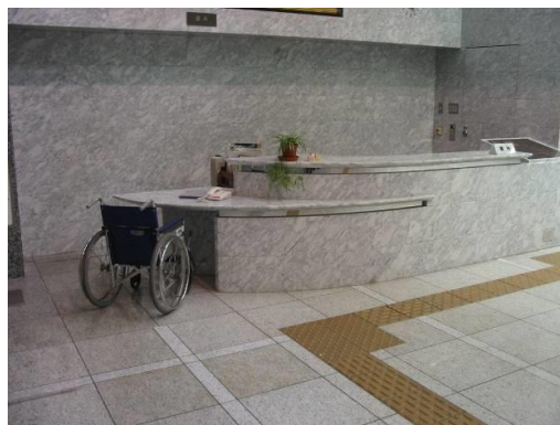
多様な方に配慮し、高さの異なるカウンターを設けた受付、及び受付までの誘導用床材の例
