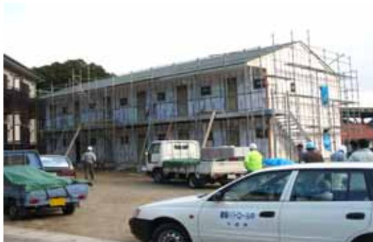
建築パトロールの様子
