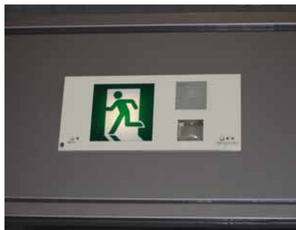
避難誘導の表示(左のピクトグラム)と非常時に点滅するフラッシュランプ(右下)と、非常放送用のスピーカー(右上)により、複数の方法で緊急情報を提供している例
