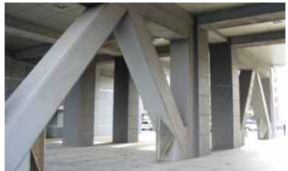
県有施設の耐震改修
