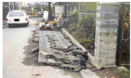
コンクリートブロック塀倒壊例
