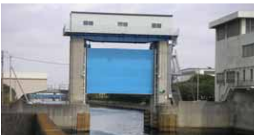
高潮対策事業 千葉港海岸（船橋地区）
