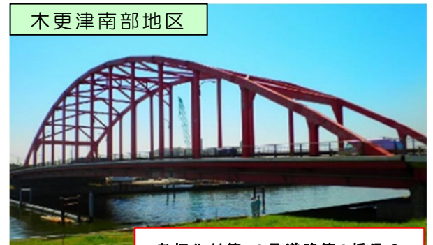
老朽化対策：2号道路第2橋梁の耐震補強
