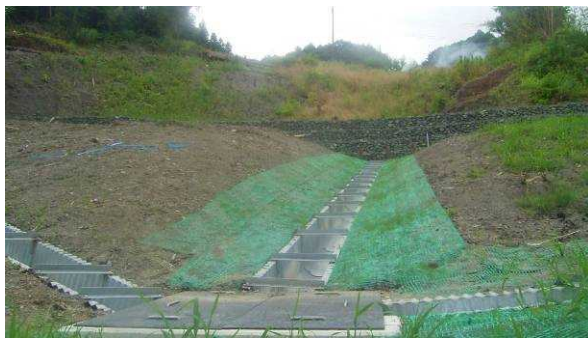
明暗渠工 (南房総市山田)
