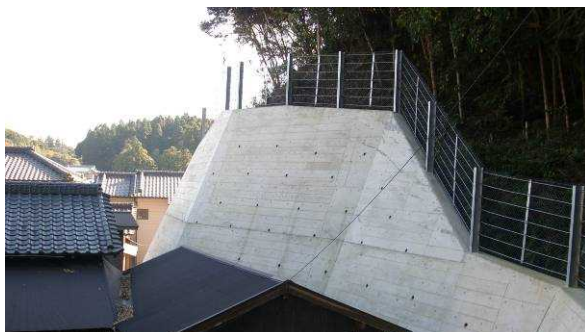
張りコンクリート工 (いすみ市大原)
