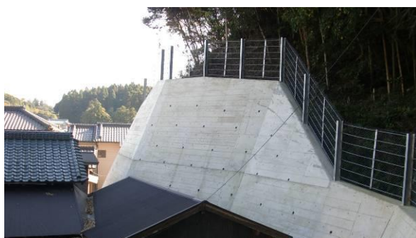
コンクリート張工 (いすみ市大原)
