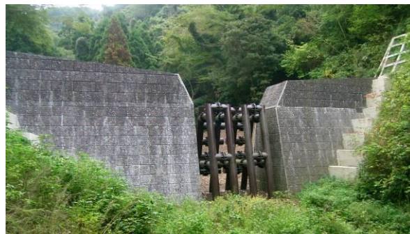
砂防堰堤工 (南房総市合戸)
