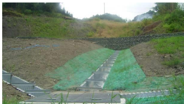
明暗渠工 (南房総市山田)
