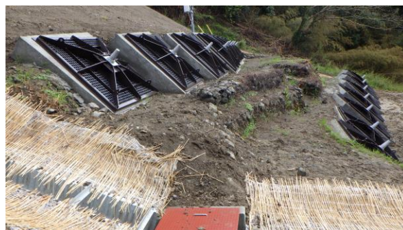
アンカー工 (南房総市増間)
