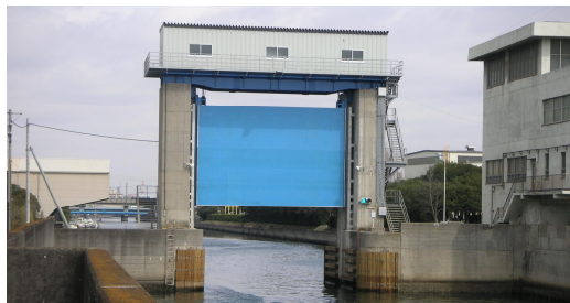
高潮対策事業 千葉港海岸（船橋地区）
