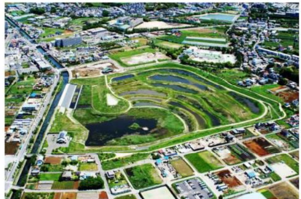
大柏川第一調節池 (市川市北方町)
