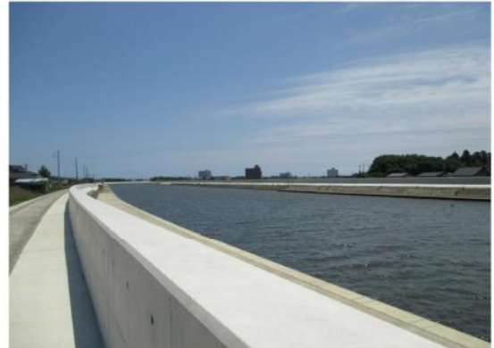
堤防かさ上げ工事完成状況 (二) 南白亀川
