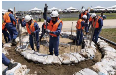
水防団による訓練（釜段工）
