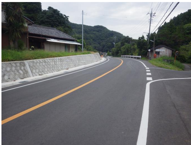
県道鴨川保田線（鋸南町） 改良済区間
