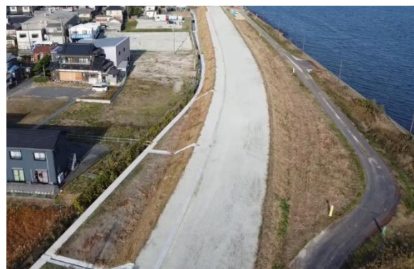
国道 356 号 銚子バイパス（銚子市）
