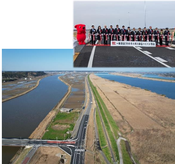
国道 356 号 小見川東庄バイパス（東庄町）
