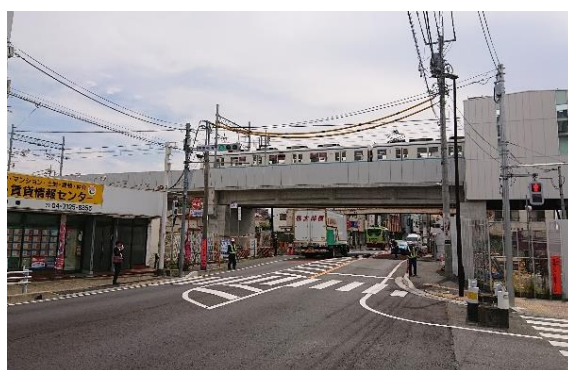
東武野田線（野田市） 高架化後
