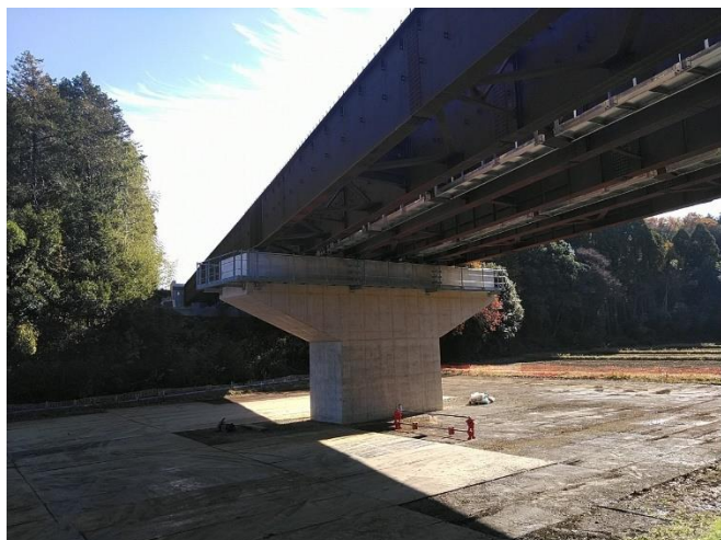
国道 296 号 八千代バイパス（八千代市）
