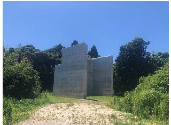
国道 297 号 松野バイパス（勝浦市） 開通区間
