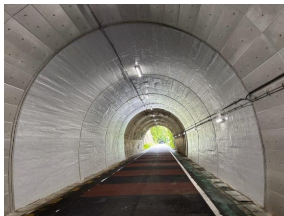
広岡隧道（君津市）令和7年5月12日現在
