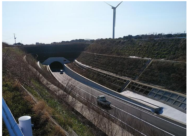
県道銚子海上線清滝バイパス（旭市）
