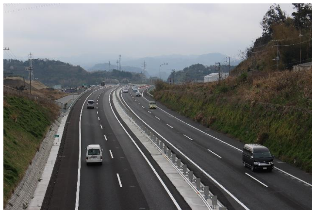
館山自動車道（富津市湊地区）
