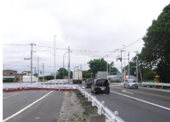
右折レーン設置後
