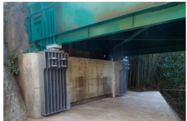
山田橋（印西市）
