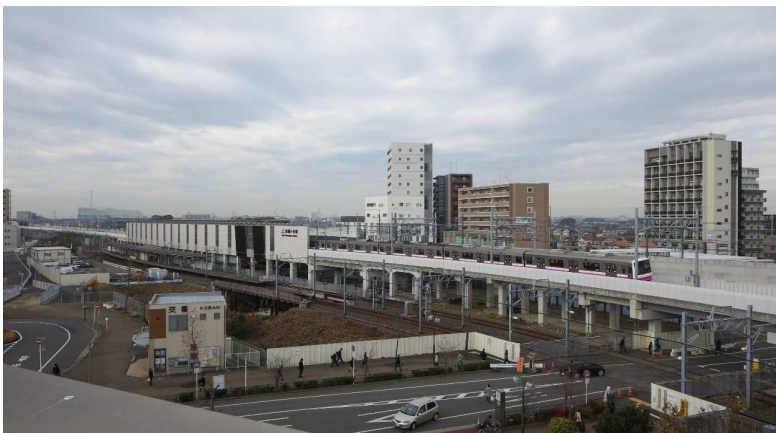
←新京成線連続立体交差事業 全線高架運行開始 (鎌ヶ谷市:令和元年12月1日)
