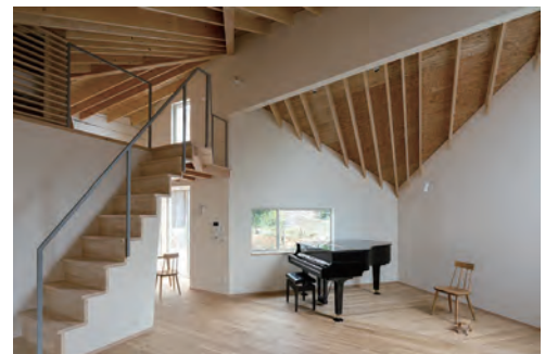
構造表しで垂木をランダムに配置した内部演奏空間 （撮影全て/中村 絵）
