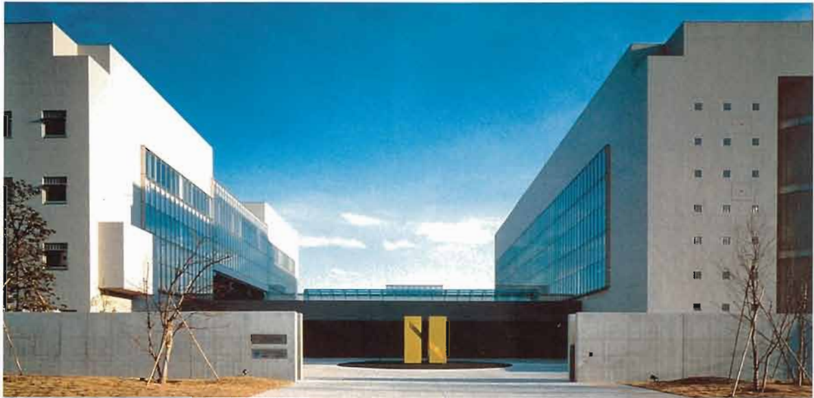
正面入口から（本館・研究棟・図書館）（撮影：篠澤建築写真事務所）
