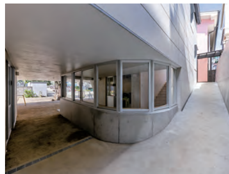
園庭と遊戯室をつなぐスロープ
