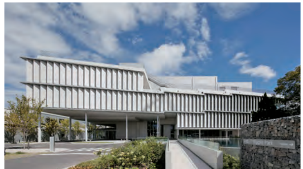
西陽に対してアルミエキスパンドメタルによるルーバーを設置。隣接するゲストを迎える緑地と一体的に整備。
