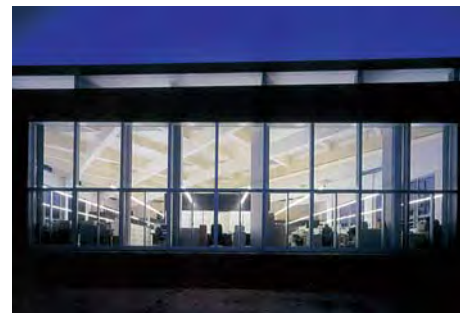
増築棟 東側立面
