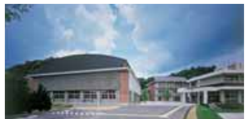
メインアプローチからの南側外観
