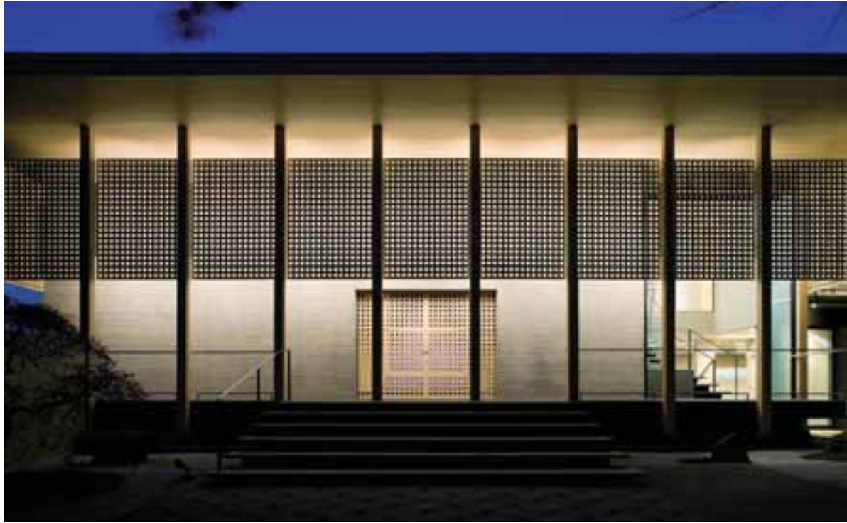
コンクリートの本堂を木造建築でくるんだ外観
