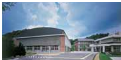
メインアプローチからの南側外観
