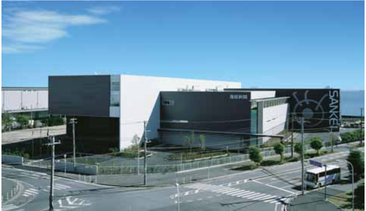
周辺環境に配慮し3つのボリュームに分節した外観
