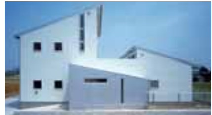
西側外観スロープからアプローチの中の玄関へ
