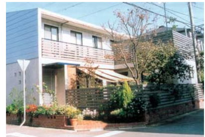
すだれの家(環境) 撮影/(株)アプル総合計画事務所
