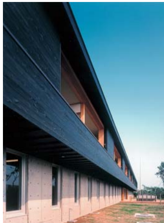
前庭からの外観
