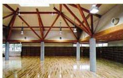
方形の屋根を支える構造材を見るようにデザイン
