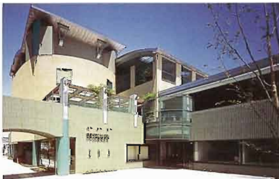
エントランス外観
