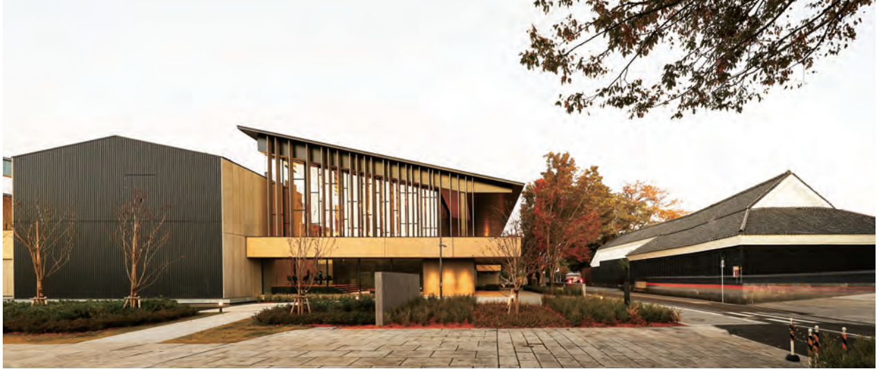
蔵や黒板塀が点在する街並みと連続した外観
