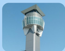
ランプセントラル タワー見学
