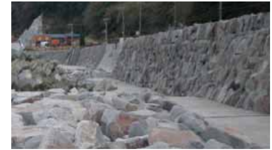
壁面への石張りにより統一感に配慮した事例
