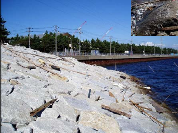
1工区完成断面の状況
