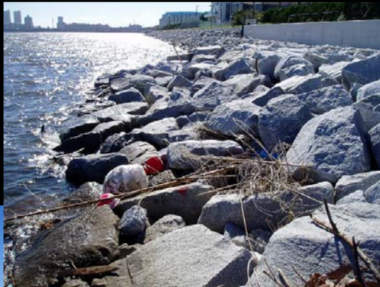
1工区乱積み部の状況
