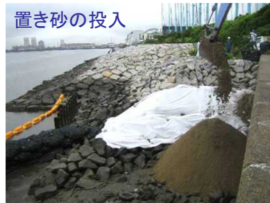
図-9 砂付け試験の目的、置き砂の投入状況(H21.7)、試験区の材料・規格及び断面図
