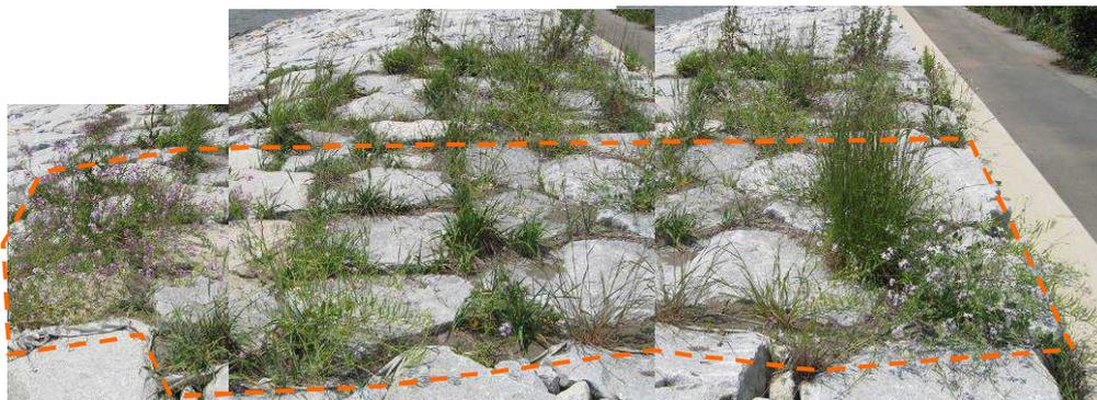
参考：緑化試験の石の間詰め・購入砂基盤(破線部内)の移植後1年2ヵ月後(H21.5)の状況
