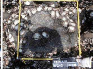
鋼矢板基部の捨石マガキが付着
