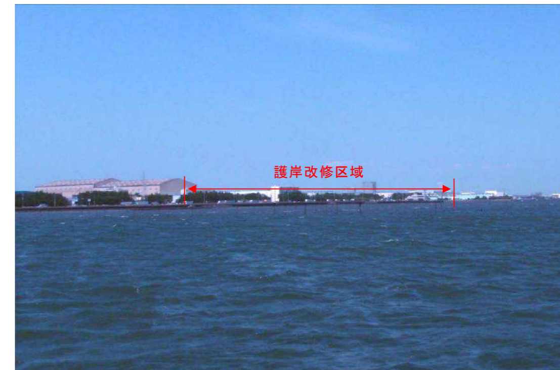
写真 6-1(1) 調査地点からの眺望の状況 (NO.1 浦安市入船地区)
