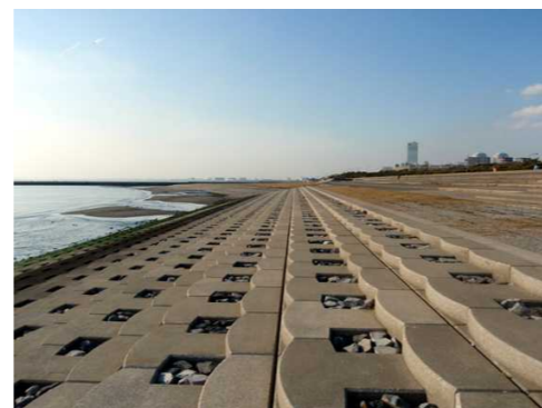
孔空き被覆ブロックによる階段護岸
