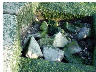
階段護岸の低潮帯 被覆ブロック表面はアオノリ属に被われている
