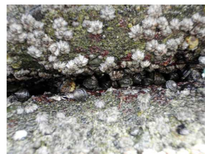
階段護岸の目地に群生するタマキビガイ、周辺はイワフジツボ (高潮帯)
