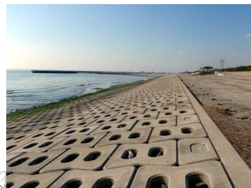
孔空き被覆ブロックによる緩傾斜護岸
