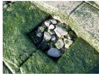
階段護岸の中潮帯 被覆ブロック表面はアオノリ属に被われている
