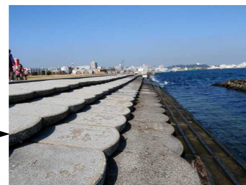
うみかぜ公園 コンクリート階段護岸 (神奈川県横須賀市平成町)
