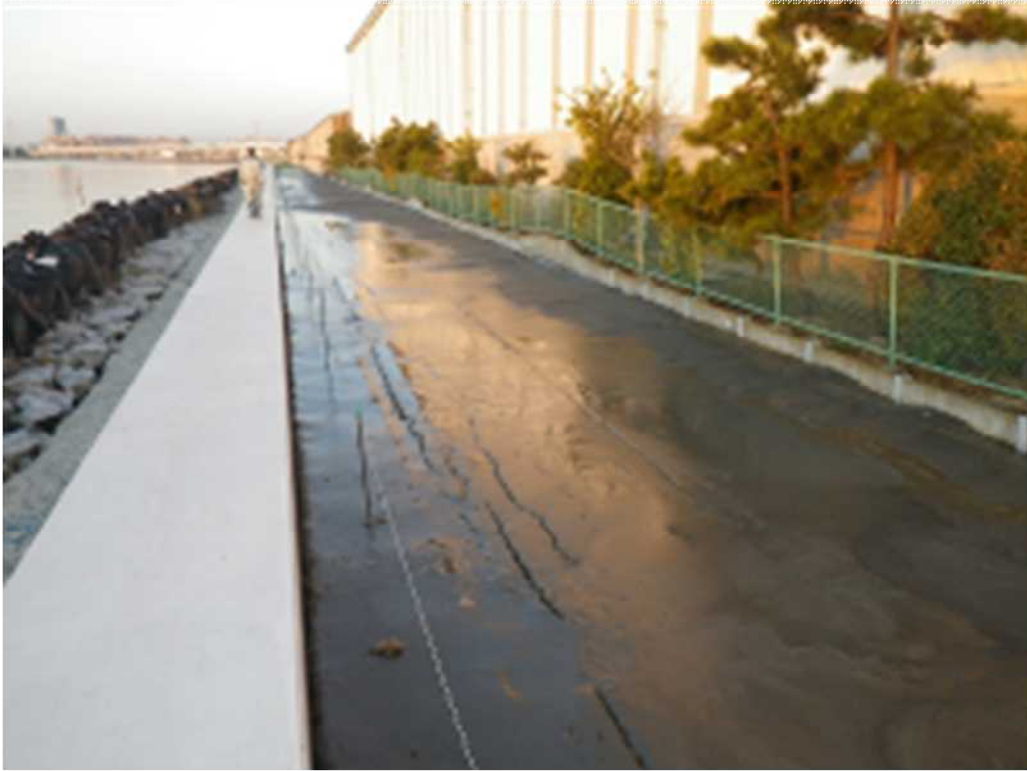
《護岸背後の道路》
