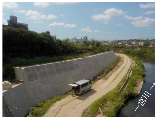
旭橋下流 (施工状況) R5.7撮影
