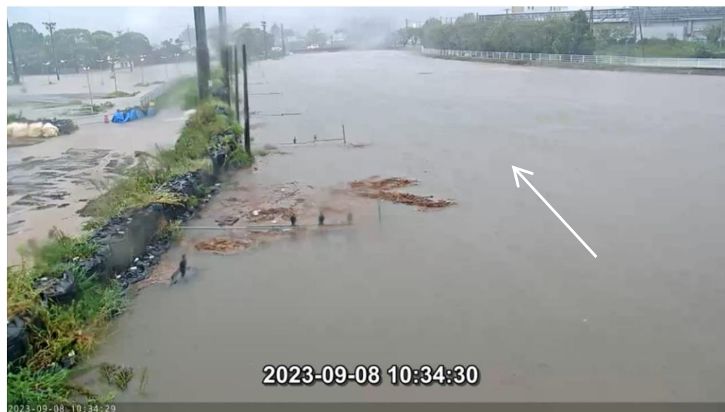
阿久川合流点（No.573付近）
