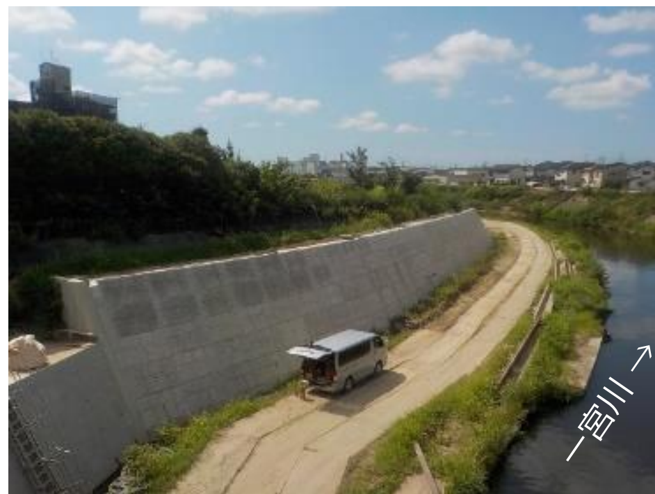
旭橋下流 (施工状況) R5.7撮影
