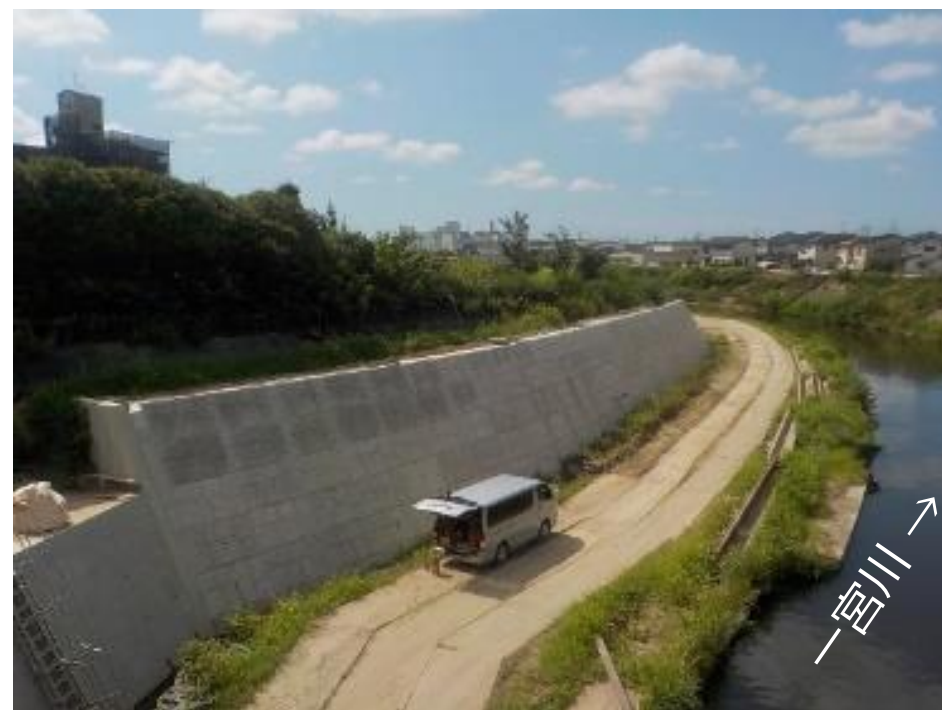
旭橋下流 (施工状況) R5.7撮影
