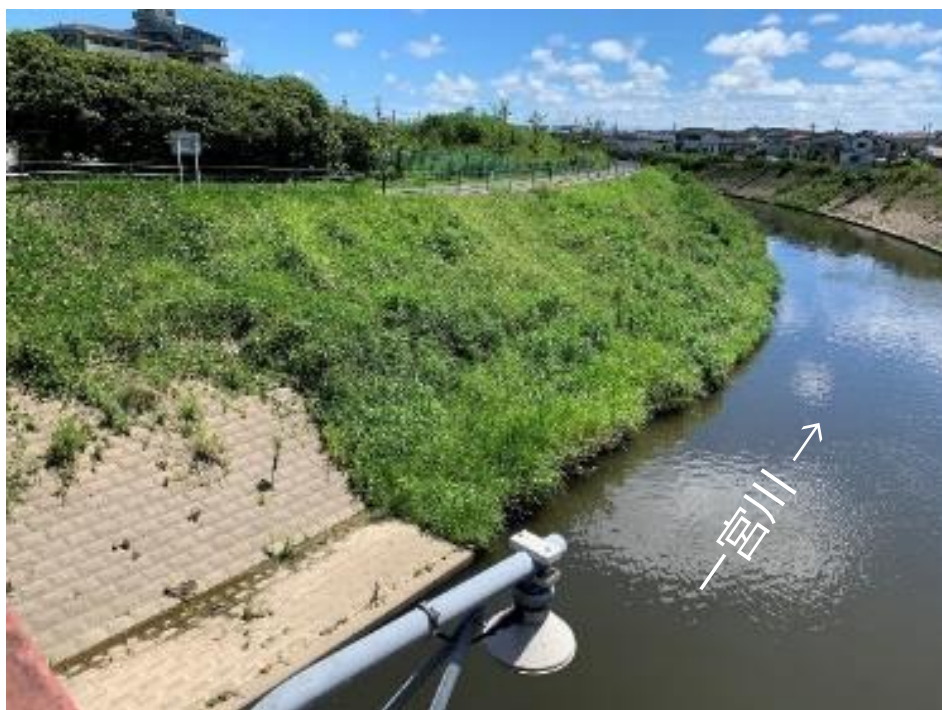
旭橋下流 (着工前) R3.8撮影
