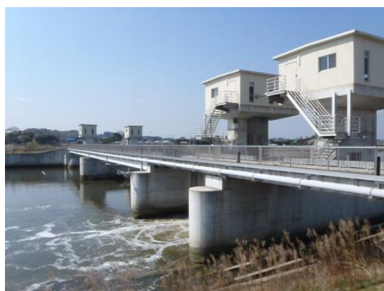
■ 現在の松潟堰の様子
