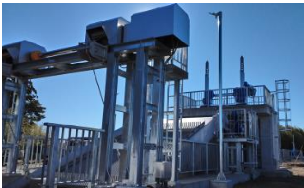
図 2-5 鷺巣稲荷前水門ポンプゲート整備
