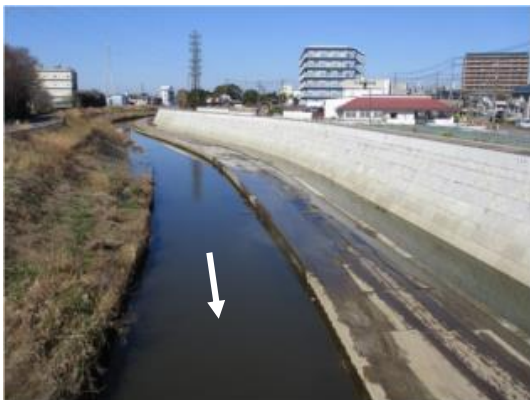
図 4-2 旭橋下流河道改修 (再掲)
