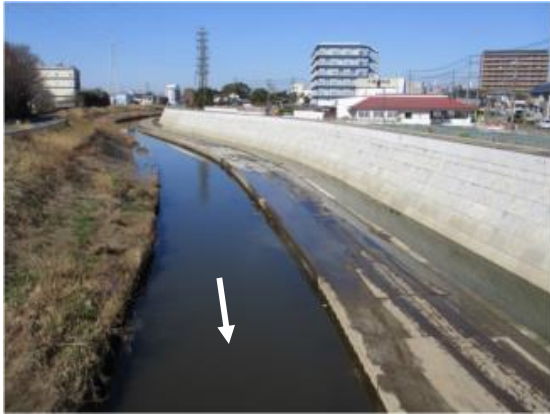
図 2-3 日進橋上流河道改修
