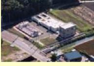
家庭排水などによる川の水の濁りやアオコの発生原因であるリンを取り除きます。約80%のリンや浮遊物を取り除き、一日最大約1万トンの水を浄化できます。
