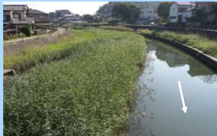
椎津川の河川状況(姉崎橋上流)
