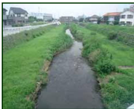
川間橋より下流側の現在の状況
