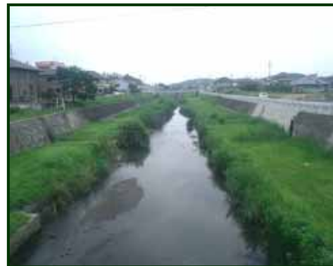
砂子橋より上流側の現在の状況
