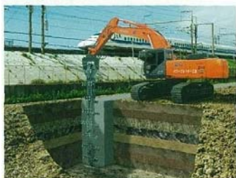
パワーブレンダー工法
