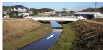
完成した区間(つばい橋下流)
