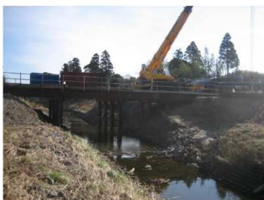
現在の工事状況
