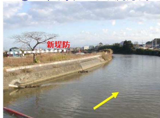
④ 旧松潟堰から下流方向
